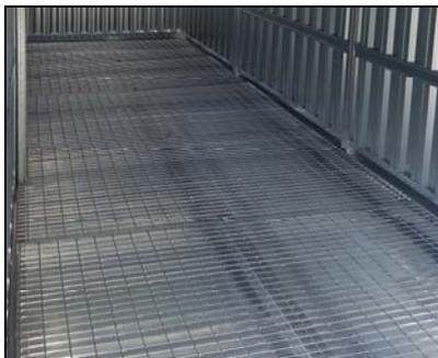
Vasca stagna di raccolta in acciaio al carbonio zincato spessore mm 2,0 dimensionata in base allo stoccaggio dei materiali secondo il DM 18/05/1995 ;
