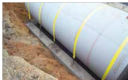
Lavaggi di serbatoi interrati
